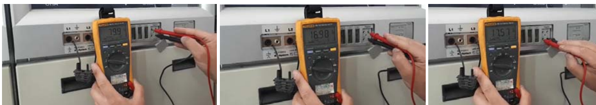
Slika 7. Izmjereni napon na IVIS indikatoru napona u fazama L1, L2, L3 (polje =H4)
